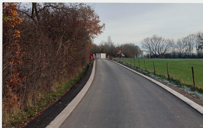
Réfection de voirie Chemin de Surisse à Bombaye
