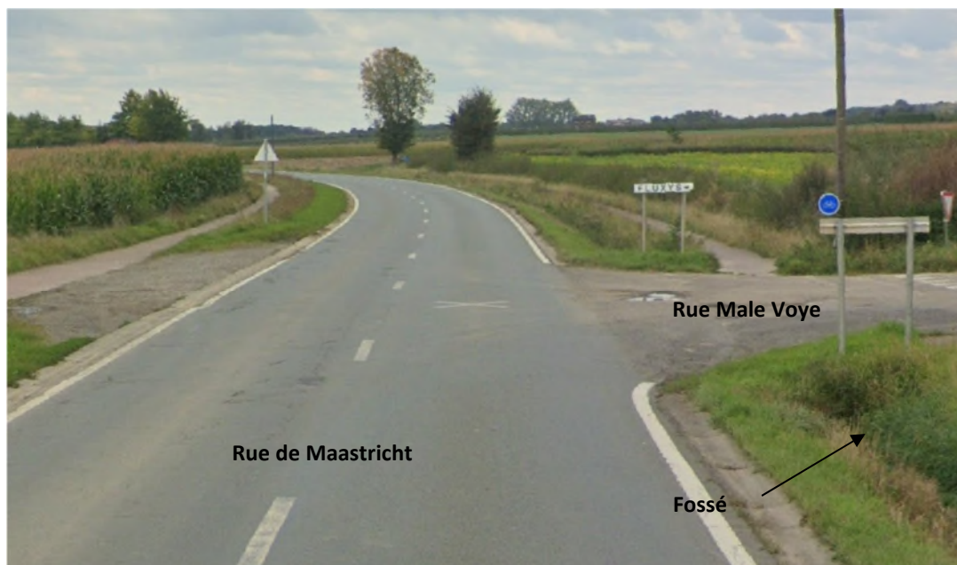
Figure 77 : Intersection entre la rue Male Voyer et la rue de Maastricht. Les avaloirs sont indiqués par les flèches (source : Google Street View – octobre 2024)
