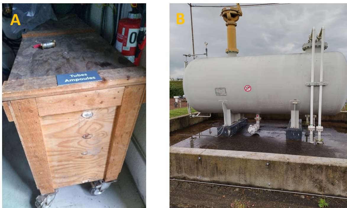
Figure 31 : Photographies de quelques contenants à déchets (source : Sertius SA). (A) Bac de récupération des ampoules usagées. (B) Citerne de récupération/stockage des condensats (13.000 l)
