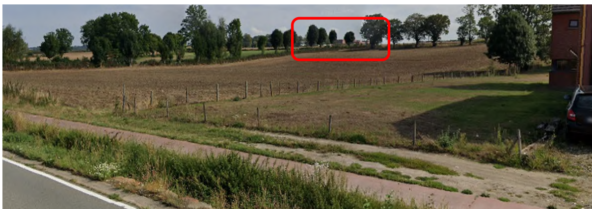
Figure 49 : Photographie 1 au niveau de la N627. Les bâtiments de FLUXYS S.A. sont indiqués par l'encart rouge. La photographie 2 (Figure suivante) montre une vue vers le site depuis le début de la rue Male Voye, à l'intersection de la N627. On constate que les bâtiments du Demandeur ne sont pas visibles.
