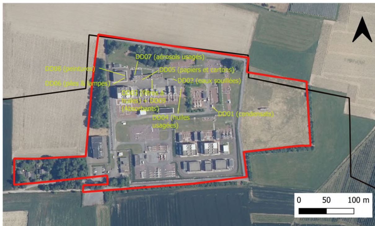
Figure 30 : Localisation de dépôts de déchets – en vue aérienne
