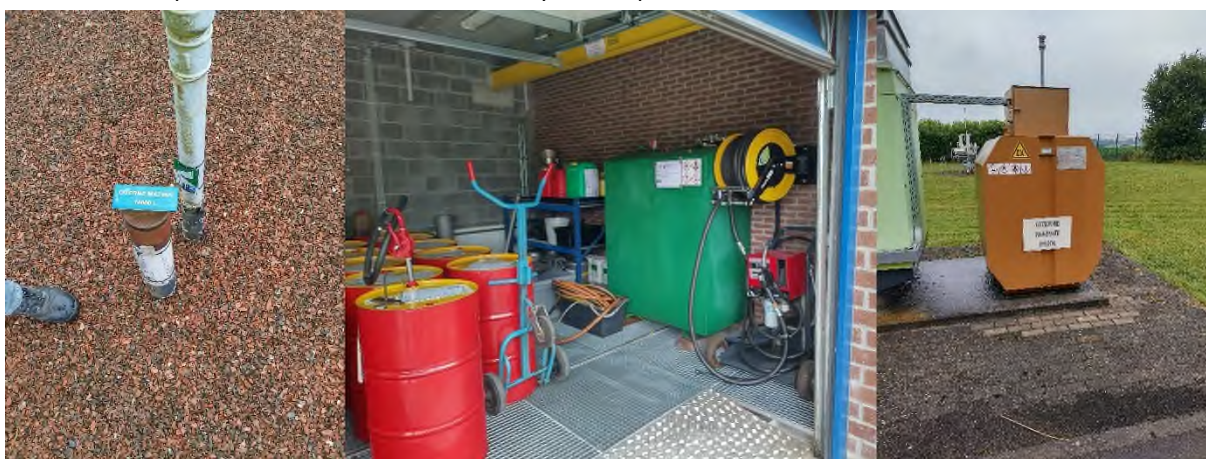
Figure 66 : Dépôts de mazout du Demandeur, de gauche à droite: citerne enterrée , cuve de distribution de carburant et groupe électrogène (source : Sertius SA)
