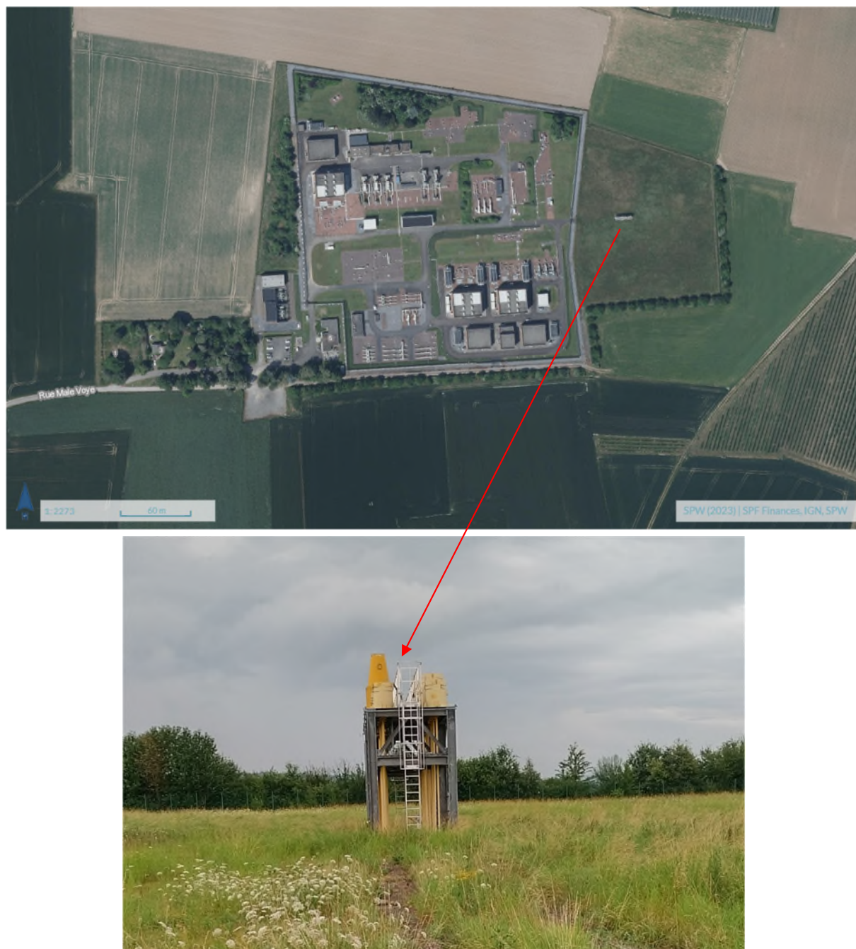
Figure 26 : Events d'évacuation (source : Sertius SA). Cette installation est située sur la parcelle P13 (189)
