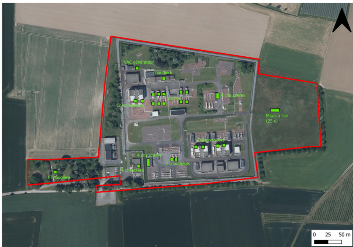
Figure 34 : Emplacement des rejets atmosphériques / cheminées – vue aérienne.
