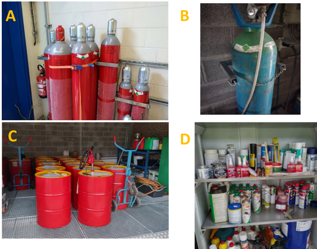
Figure 29 : Photographies de plusieurs dépôts de produits sur le site du Demandeur (source : Sertius SA) : Bouteilles d'extinction (A), Gaz sous pression (ici de l'Argon - B), Huiles neuves (C), Produits dangereux divers en petits conditionnements ( nettoyants, silicones, lubrifiants, etc. - D)
